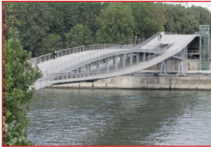
Figura 2. Passarela composta pela intersecção de dois arcos de parábola, construída em aço e madeira.
