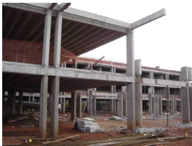
Figura 4 – Obra do Instituto de Biologia (Fonte: Laboratório de Projetos)
