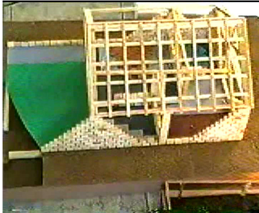
Foto 3 - Miniatura apresentando estrutura do telhado e alvenaria em execução
