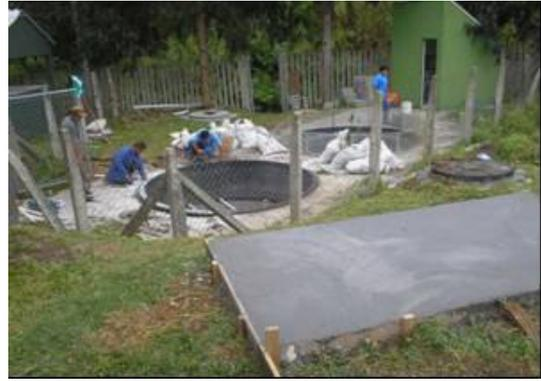
Figura 7: Foto da construção da laje para suportar as caixas de água.
