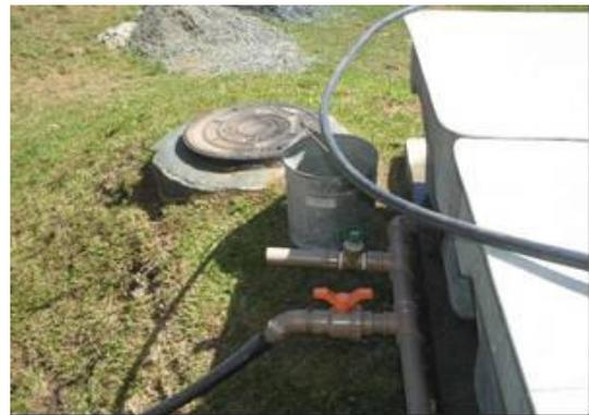
Figura 8: Fotos caixas de distribuição já colocadas sobre a laje de concreto.
