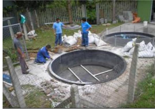
Figura 9: Fotos dos tubos que compõe o sistema de distribuição colocado no fundo do “wetland”.
