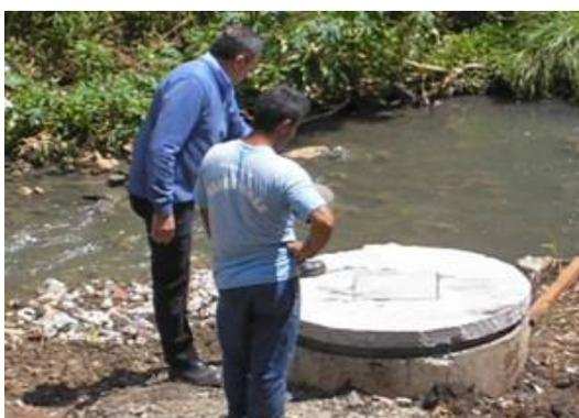
Figura 6: Fotos construção e colocação da tampa de concreto para o poço de sucção.
