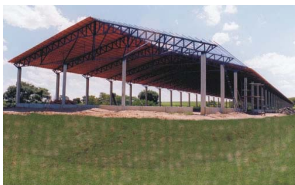
a) Cobertura com telhas cerâmicas.
