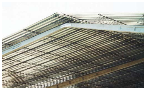
b) Cobertura com telhas de aço.
