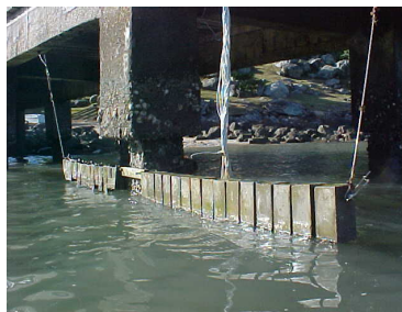
Figura 2 - Ensaio em andamento.
