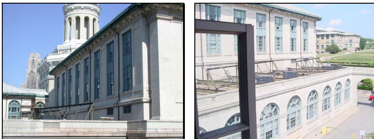
Figura 1 – Vistas frontal e lateral da asa sul do Hamerschlag Hall (CMU) (cortesia dos participantes do Grupo 4 do experimento)
