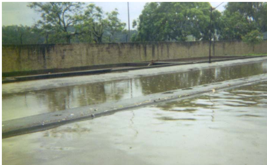
Figura 1 – Situação de emergência na Estação de Tratamento de Esgoto do Riacho Grande – nível quase extravasando para pátio de operações
