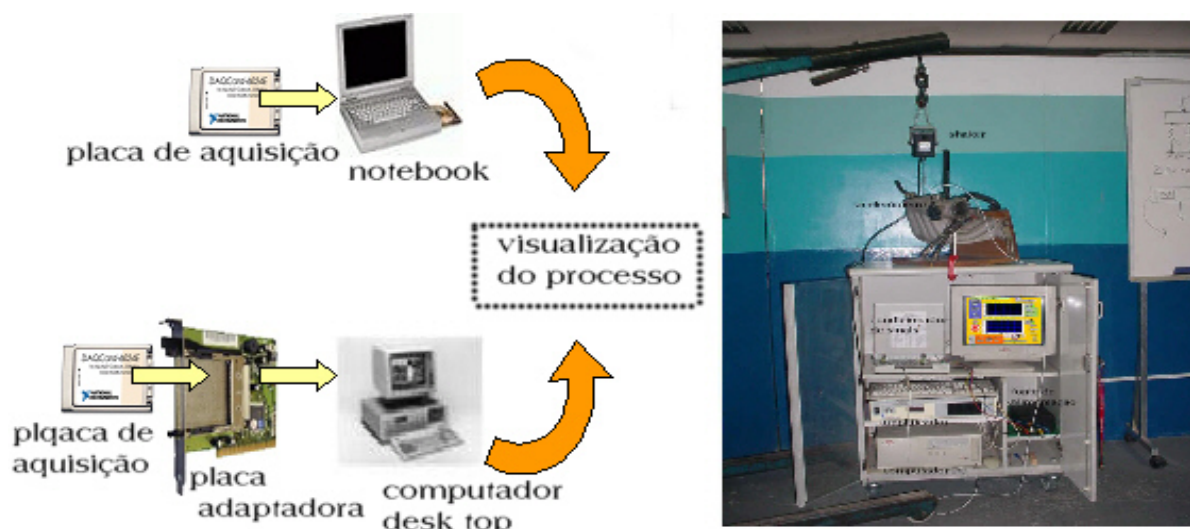
Figura 1 opções de trabalho com um notebook ou desk top e material acondicionado no armário de transporte
