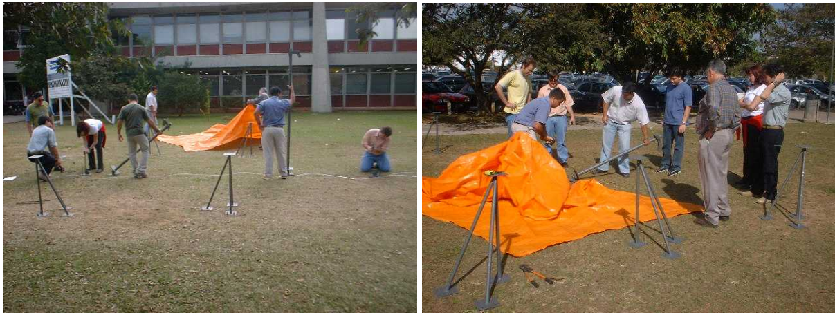
Figura 9. Alunos do 2º ciclo de 2004 durante a montagem da tensoestrutura.
