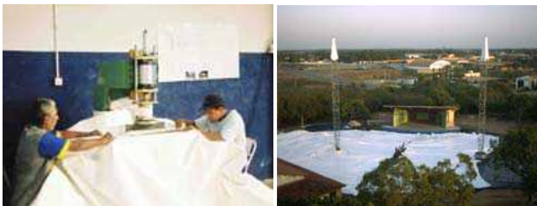
Figura 4. (a) soldagem do tecido estrutural; (b) Posicionamento da membrana no solo.
