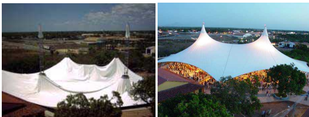
Figura 5. (a) Fixação da membrana à estrutura metálica; (b) Tensegrity já concluída.
