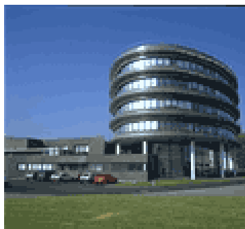
Figura 4 - Vista de um dos prédios da école - IRCCYN
