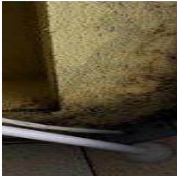
Figura 06 - Mofo e manchas provocados por insuficiência de ventilação - Domicílio VI
