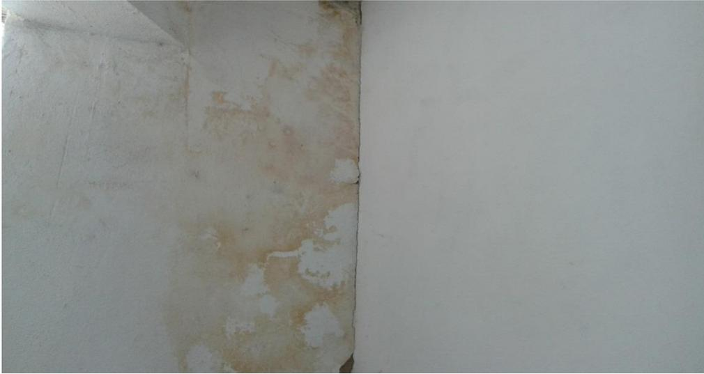
Figura 01 - Manchas causadas pela umidade no Domicílio I
