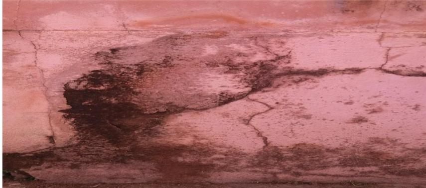
Figura 05 - Ocorrência de bolor por arremate inadequado no muro - Domicílio V
