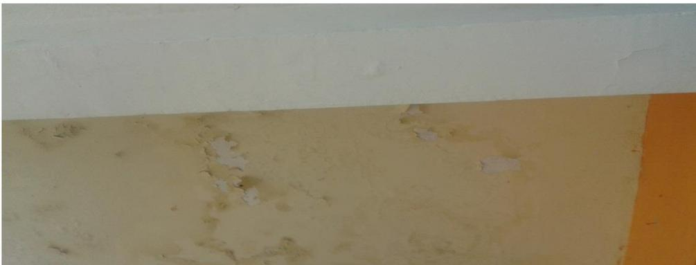
Figura 02 - Presença de eflorescência ocasiona por problemas de execução no Domicílio II
