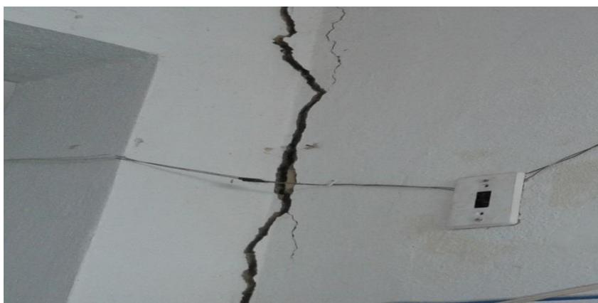
Figura 09 - Trinca provocada pela expansão dos tijolos – Domicílio IX
