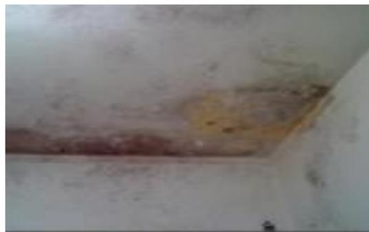
Figura 07 - Bolor ocasionado por infiltração na laje – Domicílio VII
