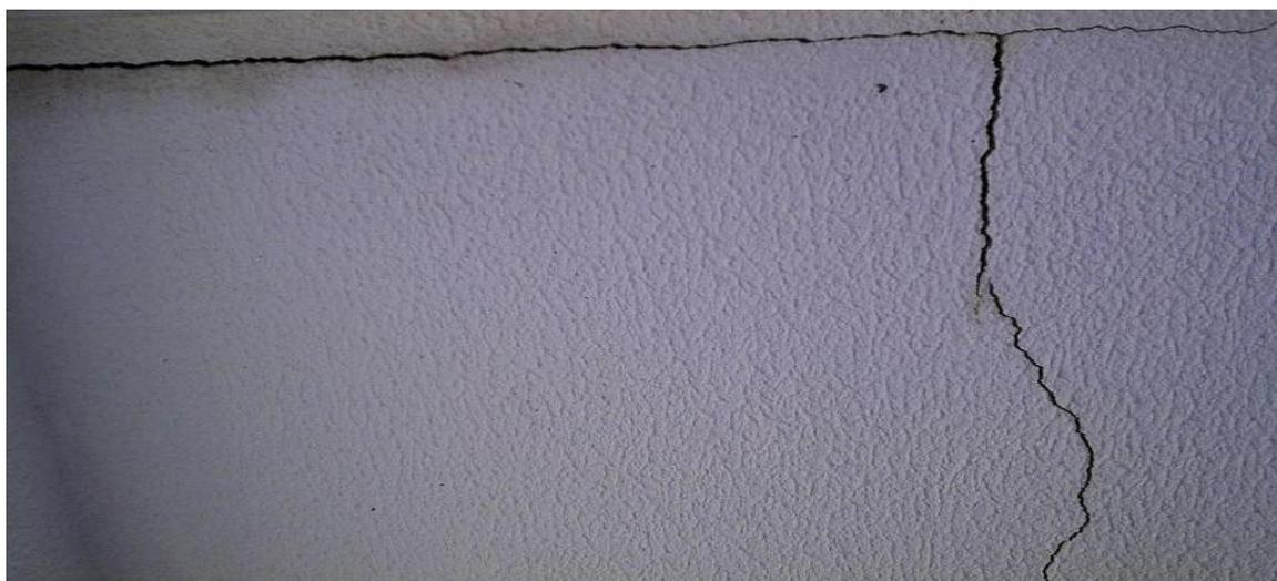
Figura 08- Fissuramento vertical – Domicílio VIII
