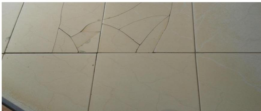
Figura 10 - Trincas no piso – Domicílio X
