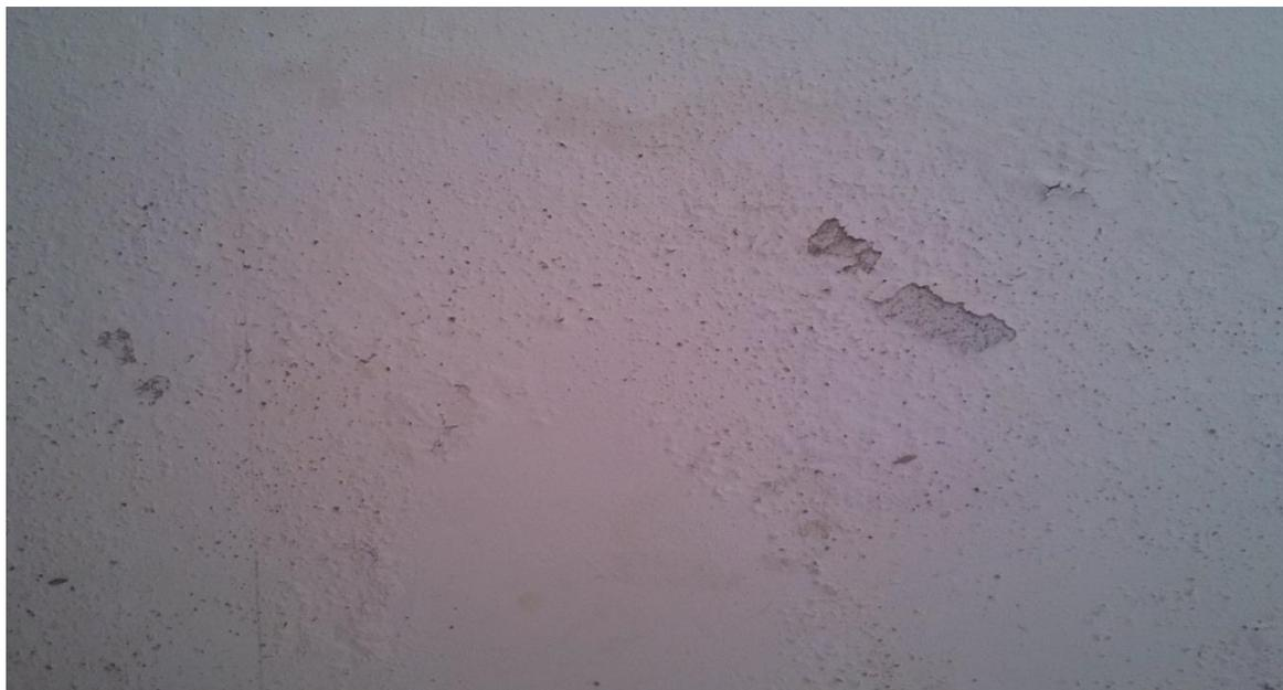
Figura 04 - Manchas e eflorescência ocasionadas pelas águas da chuva -Domicílio IV
