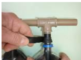
Fig.13 vedação conexão
