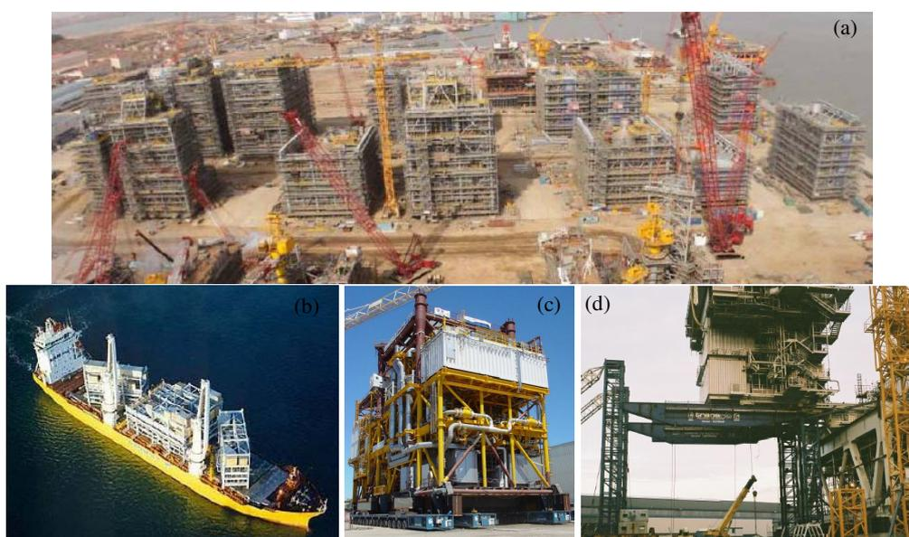
Figura 2 - (a) Módulos industriais sendo fabricados; (b) transportados via marítima; (c) transportados via terrestre; (d) montados no local da planta (Mlady, 2010; Beaudoin, 2010).
