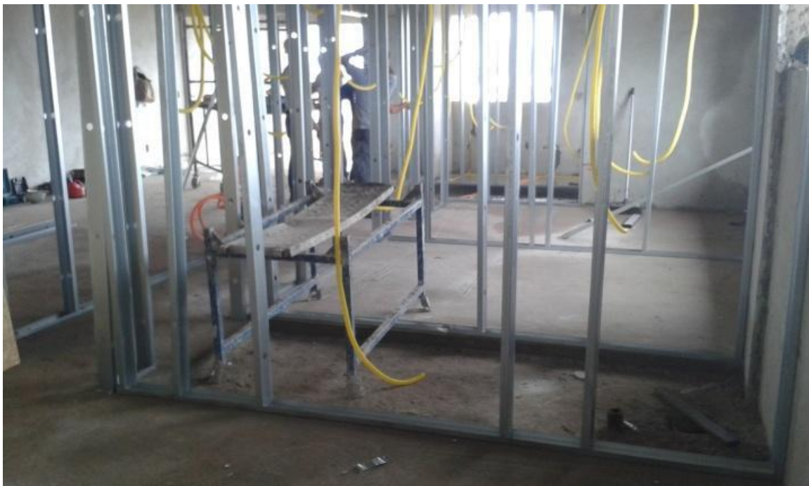
Figura 4: Montantes já fixados
