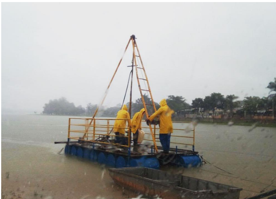
Figura 1 – Sondagem SPT Subaquática utilizando flutuante.
