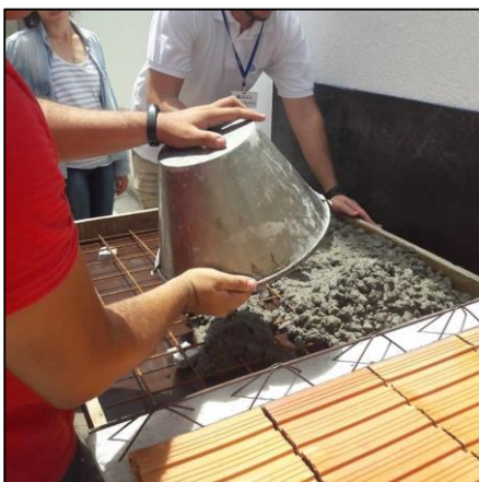
Figura 6 – Concretagem de laje
