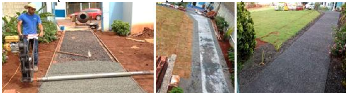
Figura 3 – A esquerda o operador da máquina em execução, na foto do meio o pavimento recém descoberto depois de 7 dias de cura e a direita o piso pintado com execução finalizada
