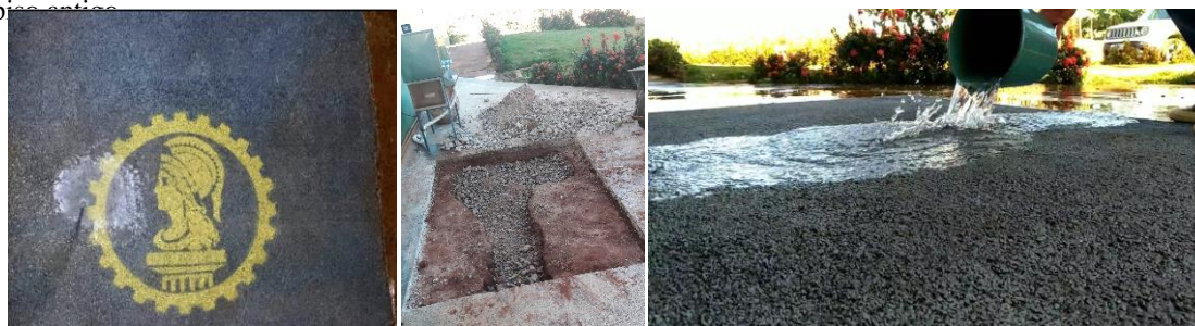
Figura 1 – As fotos da esquerda e da direita mostram o piso finalizado com água sendo derramada sobre o pavimento permeável. Na imagem do centro o detalhe da base sendo preenchida com os agregados reciclados do piso antigo.
