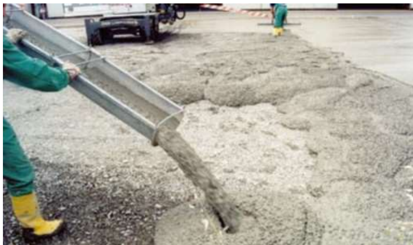
Figura 1- Concretagem do piso de Aeroporto em Bologna.
