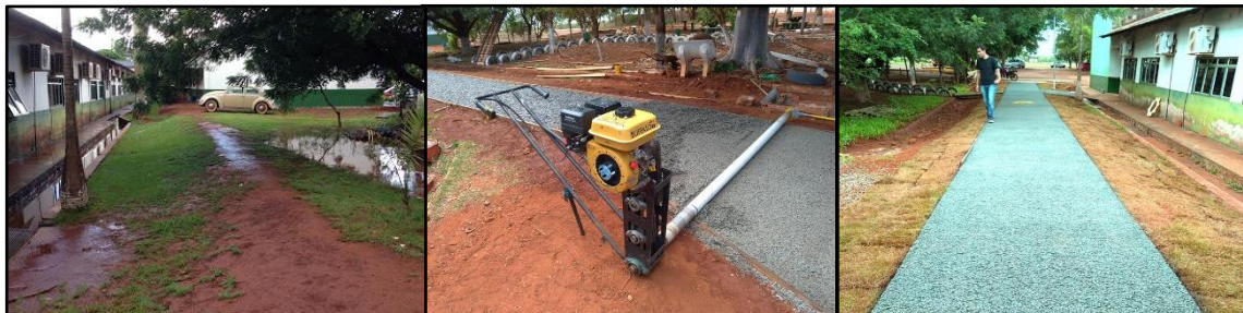
Figura 4 - Antes, durante e o depois da execução da calçada permeável.
