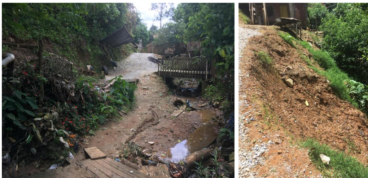
Figura 2 - Comunidade Vila Nova (Colombo-PR): Seção crítica à inundação onde foi projetada a Parede Krainer e a passagem e registro de deslizamento de terra – Local de atuação projeto GeoProjetos Sociais.
