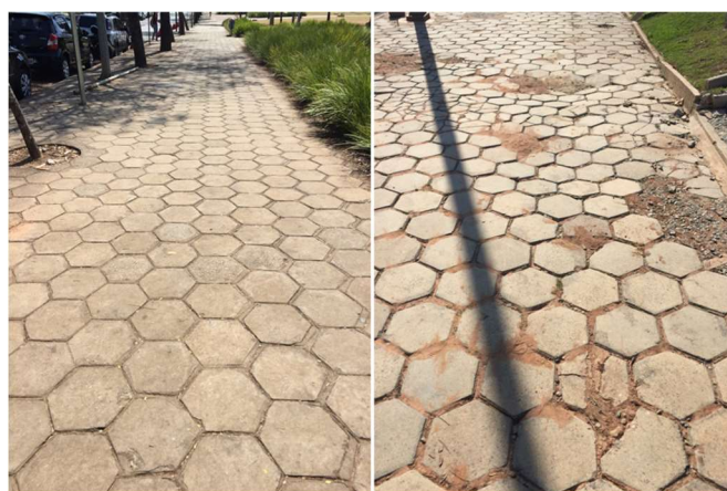
Figura 2: Piso das calçadas tipo lajota sextavada de concreto e superfície irregular na calçada.
