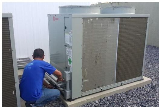
Figura 5: Manutenção de self contained
