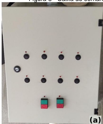
Figura 8 - Caixa de comanda instalada em campo (a) visão externa e (b) visão interna.
