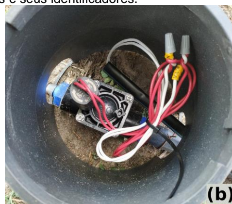
Figura 7 - (a) Exemplo do esquemático de ligação e distribuição das válvulas em campo com as caixas de passagem. (b) Válvula solenoide de 1" devidamente instalada e identificada. (c) Caixa de passagem instalada com condutores e seus identificadores.
