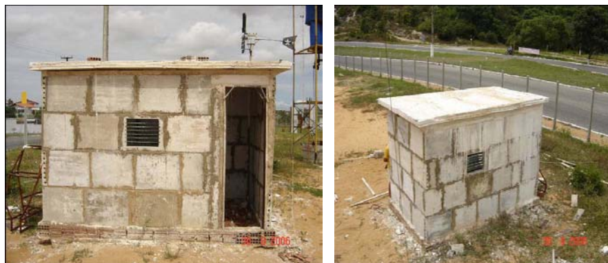
Figura 3 – Unidade habitacional construída com painéis de concreto leve. Fonte: Souza et al., 2006
