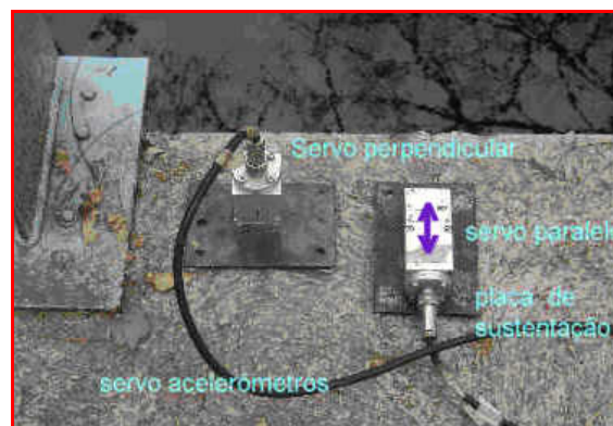
Figura 5. Fixação dos servos acelerômetros e posicionamento sobre o piso da passarela.
