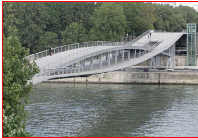
Figura 2. Passarela composta pela intersecção de dois arcos de parábola, construída em aço e madeira.
