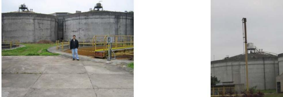
Figura 6 – Digestores anaeróbios – ETE Barueri. Esq: primeiro autor em primeiro plano. Dir: Digestor com tubulação destinada à queima do excesso de gás do digestor.
