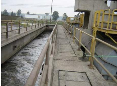
Figura 1 – Tanque de chegada do esgoto após a elevatória -- ETE Barueri.
