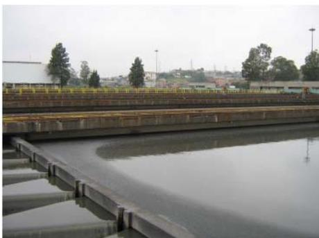
Figura 3 – Saída do decantador primário rumo ao tanque de aeração - ETE Barueri.
