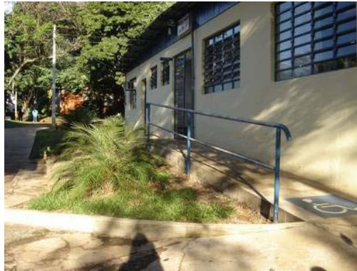
Figura 07 – rampa para acesso de cadeirantes e pessoas com mobilidade reduzida
