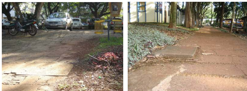
Figura 04 – passeios degradados e tampa da caixa de inspeção localizada no acesso
