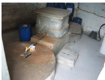
Figura 11. Sistema de tratamento da água obtida da fonte localizada no ponto 1.
