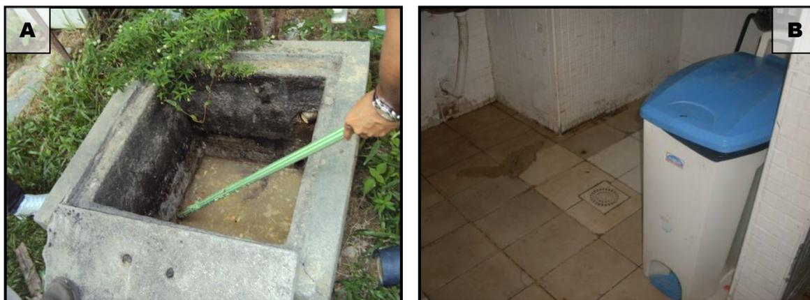
Figuras 04A e 04B: Caixa de gordura sem septo e ralo com grelha fixa.
