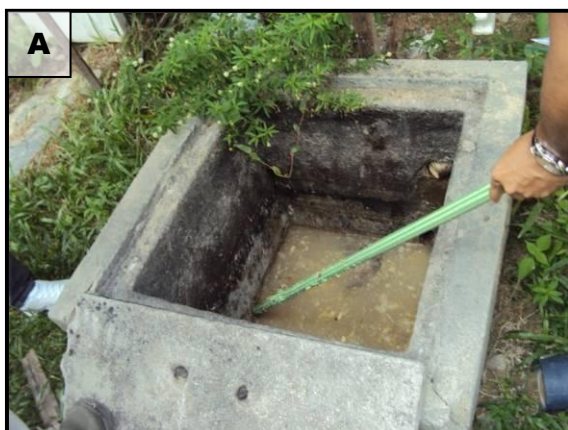
Figuras 04A e 04B - Caixa de gordura sem septo e ralo com grelha fixa.
