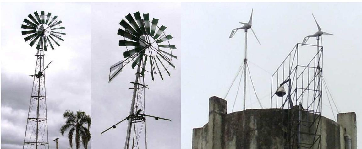
Figura 2: a) Catavento utilizado no bombeamento de água para fertirrigação. Vista normal e ampliada. b) Aerogeradores instalados sobre caixa de água no Colégio Politécnico - UFSM.
