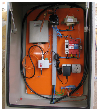
Fig. 4 – Caixa robusta para abrigo de transmissores ópticos
